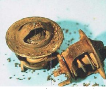
الصدأ و التآكل يعلّو البوابة لعدم وجود مثبطات منع الصدأ و التآكل
